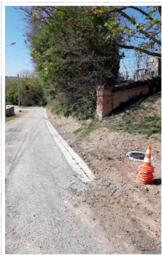
Assainissement Chemin Esplas
